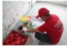
油漆施工 油漆施工前应先对基层进行处理，涂刷底漆后再涂刷面漆，涂刷面漆时应注意涂刷均匀，避免出现漏刷、漏涂等现象。
